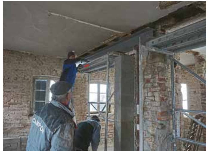
Auf Stahlrohren rollt der Träger an seinen Bestimmungsort
