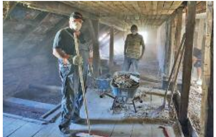
Aufräumarbeiten im 1. OG
