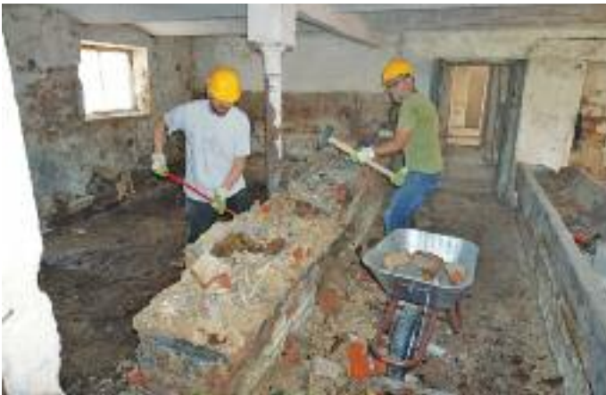
Abbrucharbeiten im Stall
