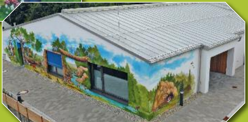
Fassade fotografiert aus dem Nachbarhaus (Foto: Georg Brauneis)
